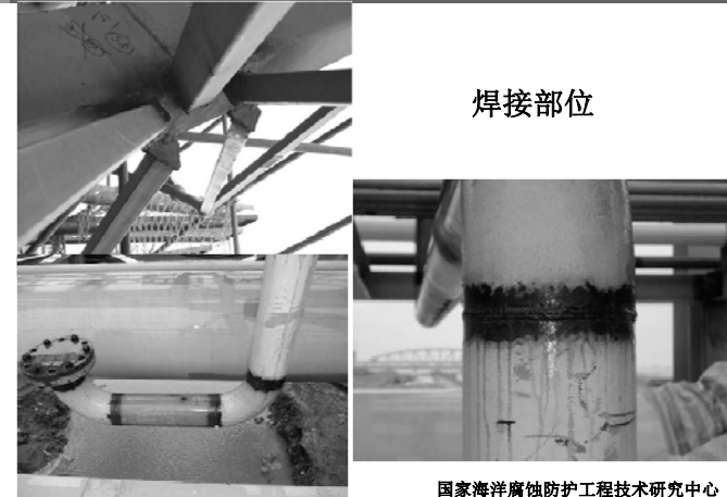
焊接部位腐蚀严重
